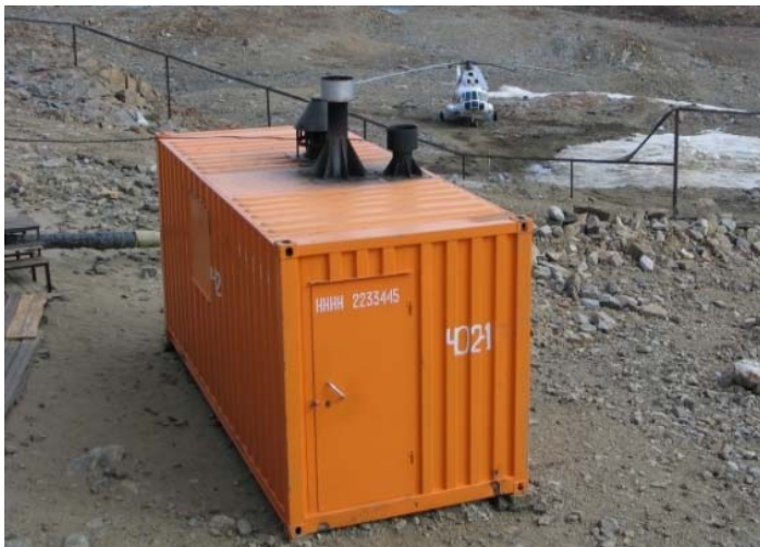
Рисунок 1. Инсинераторный модуль на станции Новолазаревская
